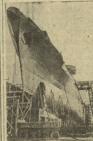
VOKIETIJOS DEMOKRATINĖ RESPUBLIKA. Rostoko laivų statykloje nesenai į vandenį nuleistas pirmas krovininis 10.000 tonų talpos ir 157,6 metro ilgio laivas. Šis laivas turi keturius dizelinius motorus, kurių kiekvienas po 2.400 arklio jėgų. Laivo greitis iki 16,5 mylių į valandą. Nuotraukoje: naujas laivas prieš nuleidžiant į vandenį.
