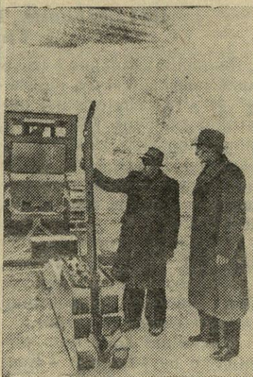
Lietuvos TSR Mokslų akademijos Kauno melioracijos institutas padeda respublikos kolūkiams įdiegti naujas melioracijos priemones dirbtiniam drėkinimui ir arimo nusausinimui. Instituto melioracijos sektorius suprojektavo savo eksperimentinėje dirbtuvėje ir pagaminą naujo tipo drenažinį plūgą, kuris jau sėkmingai išbandytas atliekant melioracijos darbus „Poginės“ tarybiname ūkyje, „Bolševiko“ ir kituose kolūkiuose. Plūgo konstrukcija yra labai paprasta. Juo atliekamas kurminis drenavimas yra daug pigesnis už drenavimą moliniais vamzdeliais. Projekto autorius yra instituto mokslinis bendradarbis D. Stočkus. Nuotraukoje: naujasis kurminio drenavimo plūgas „KDP-2“. Kairėje — instituto moksliniai bendradarbiai D. Stočkus ir K. Pilkauskas.
