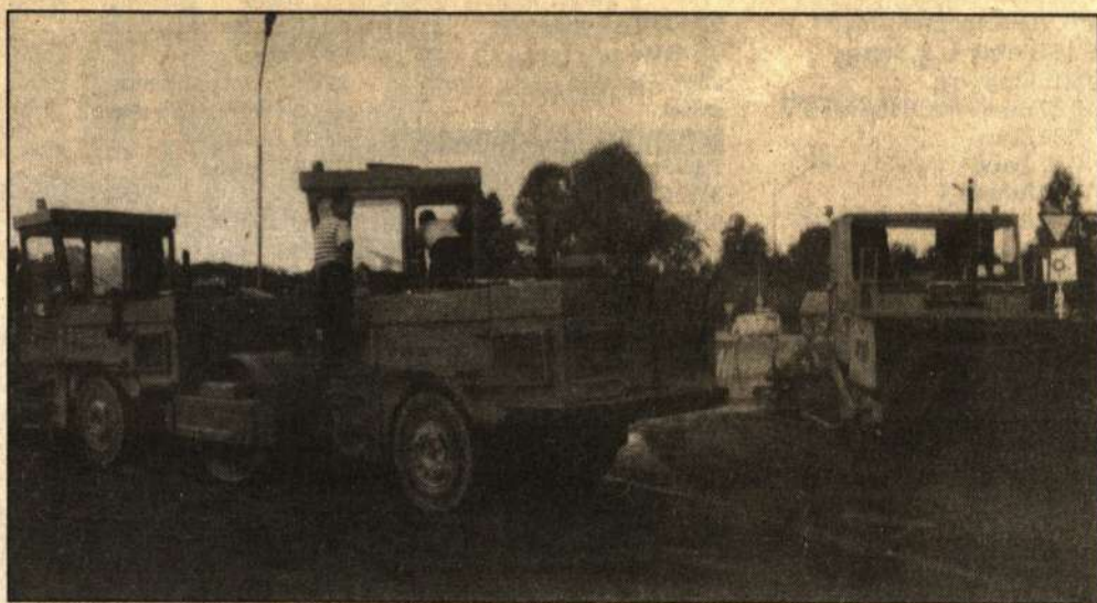
Asfaltuojama Kupiškio miesto Technikos gatvė.
