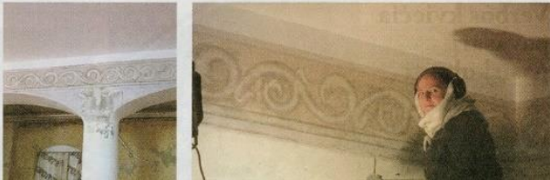
Restauratorė Jurgita Krilavičienė Kupiškio viešosios bibliotekos direktoriui parodė, kokios bus restauruotos bibliotekos naradu sienės.
